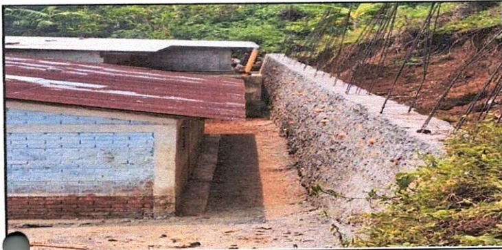
Foto 3: MURO TERMINADO AL 100%
