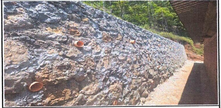
Foto 2: MURO TERMINADO AL 100%
