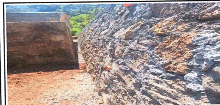
Foto 5: MURO TERMINADO AL 100%
